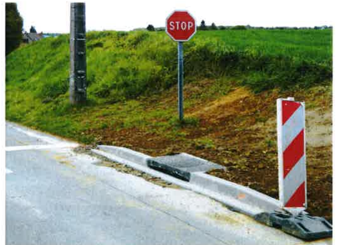
Ecoulement des eaux pluviales amélioré rue du chêne Godard
