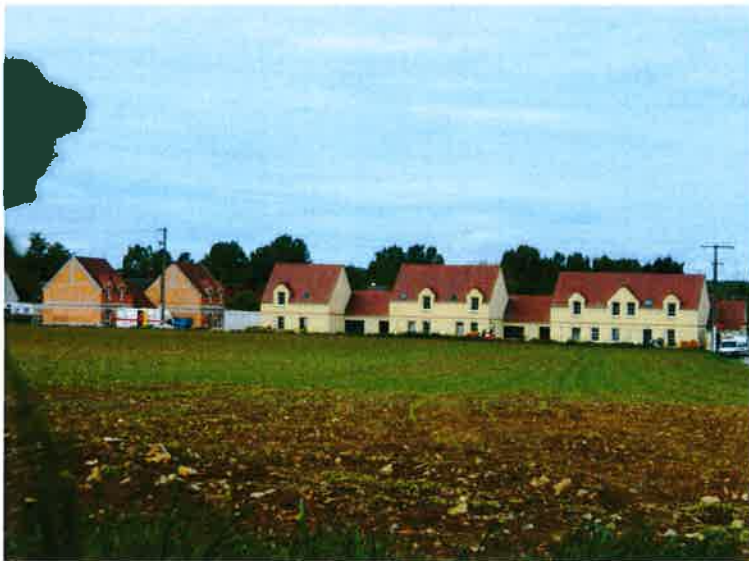
Les travaux avancent pour les appartements rue de Merlemont
